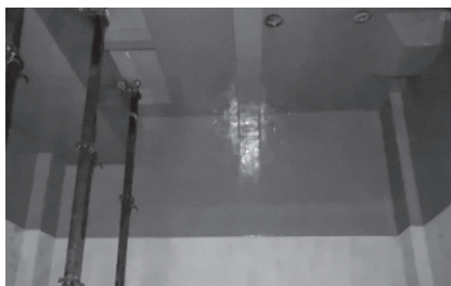
硝化槽防食工事
