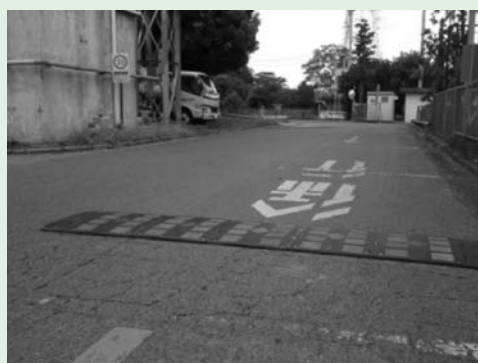
道路の上に設置されたハンプ
