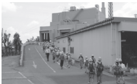
ごみ処理施設（焼却炉）
