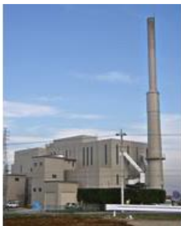
久喜宮代清掃センター ごみ処理施設
