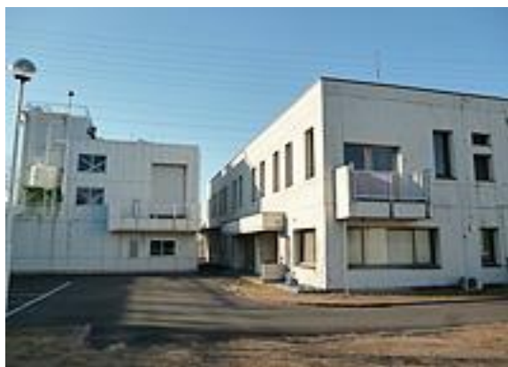
久喜宮代清掃センター し尿処理施設
