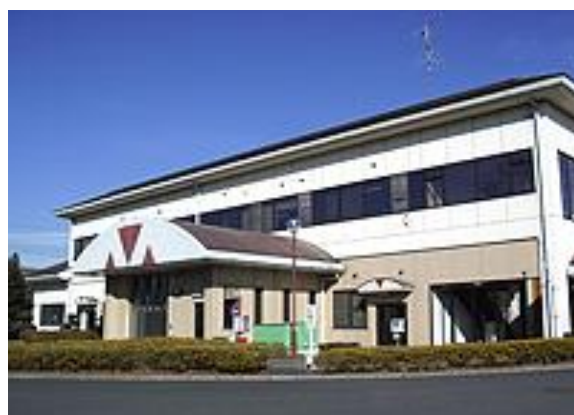
八甫清掃センター し尿処理施設
