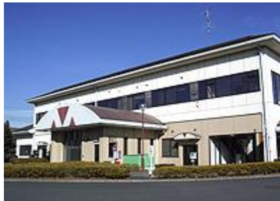
八甫清掃センターし尿処理施設
